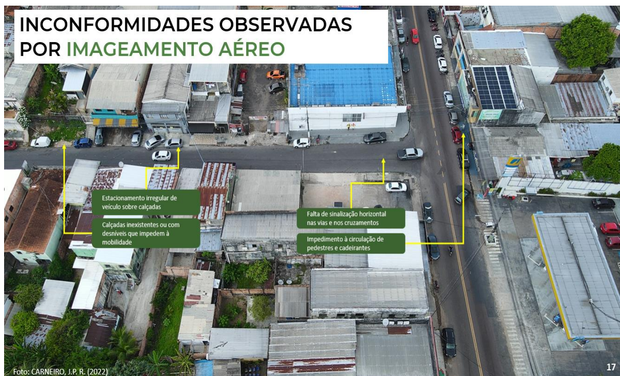
Figura 23. Inconformidades encontradas nas visitas técnicas – Bairro Alvorada.
