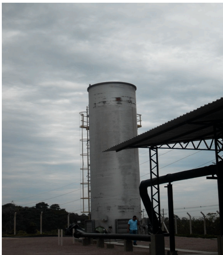
Fig. 10: Flare: cilindro fechado de grandes proporções onde é realizado a queima do biogás.
