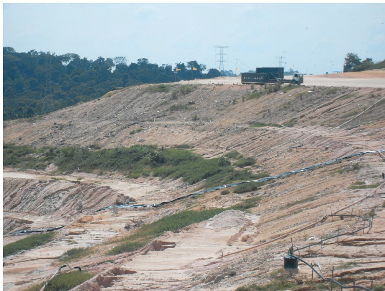
Fig. 3: Ausência de recobrimento vegetal nas células de deposição.
