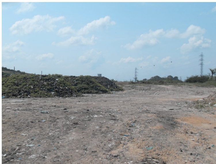
Fig. 8: Ausência de sistema de drenagem de águas pluviais.
