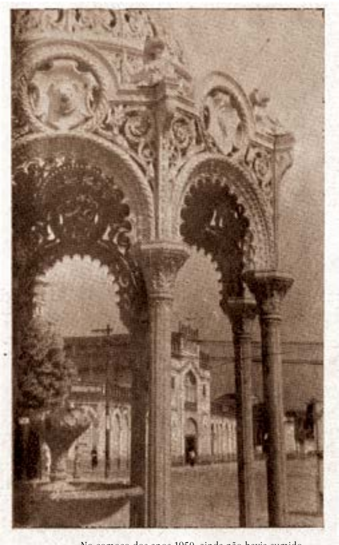
No começo dos anos 1950, ainda não havia sumido da paisagem urbana de Manaus o chafariz em ferro fundido que ficava na Treze de Maio (Getúlio Vargas), quase no cruzamento com a Sete de Setembro, entre a fachada leste do Gymnasio e o Cine Politeama. Nesta foto, publicada no álbum Manaus 1948 , aparece em segundo plano o Cine Guarany, que foi ao chão na década de 1980. O Politeama desapareceu na transição dos anos 1960-70.
